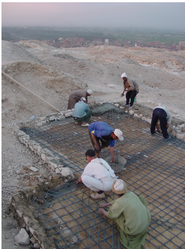
fig. 18 : construction du plafond de la salle d'offrandes.
