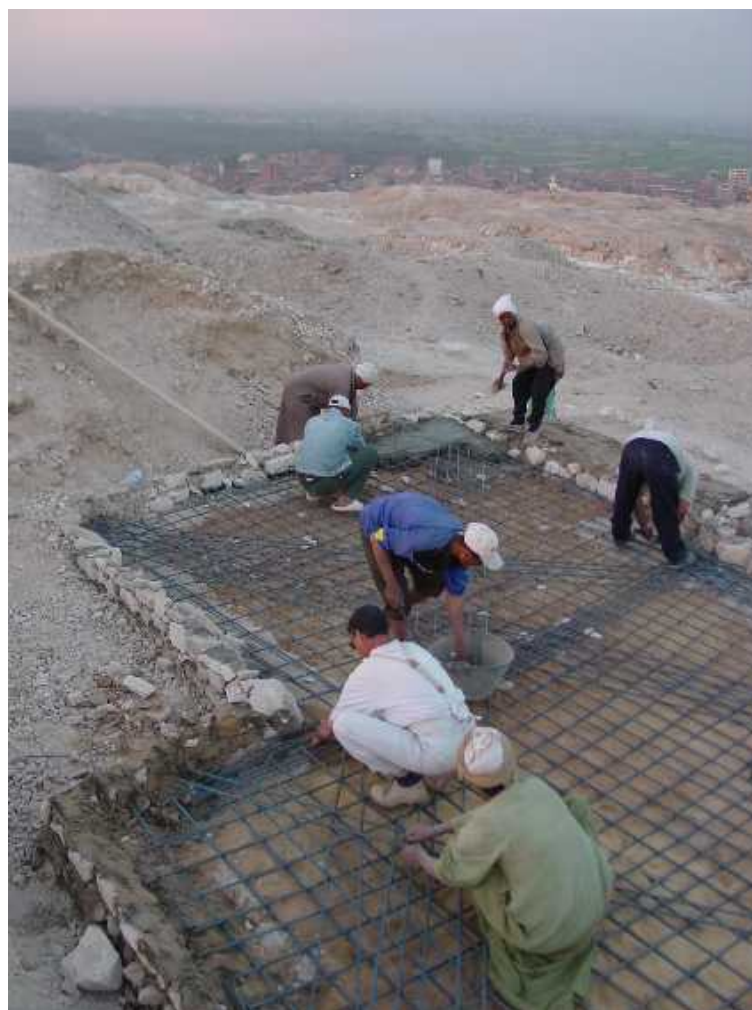
fig. 18 : construction du plafond de la salle d'offrandes.
